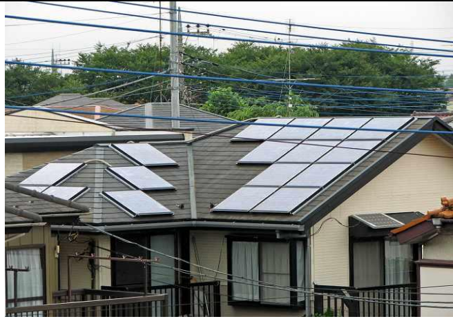
自宅の太陽電池パネル（南面・南西面） 2.46kw
