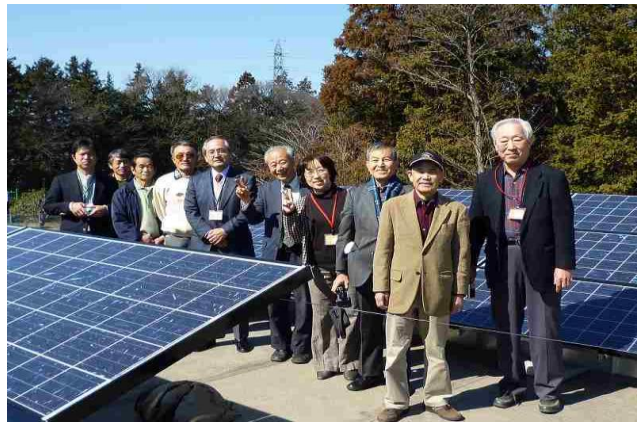
大野台こどもセンターの太陽電池パネル 3.42kw
